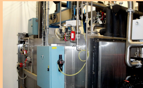
Lyophilisateur LN2 en cours de rénovation
